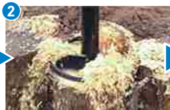
バックホーを操作し、切削
