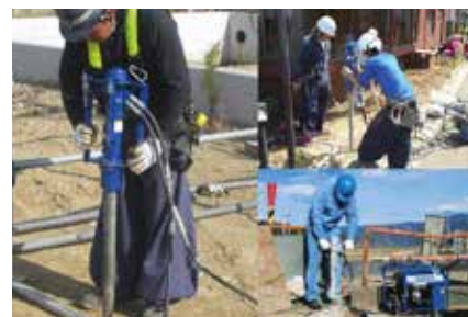
道路工事、建設工事等で使用される小型建設機械
