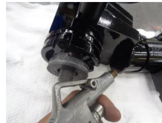
【写真4: ジョイント G 小穴 へのエアードライヤー】
